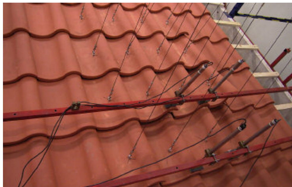
Een speciale proef levert de sterkte van het systeem, bestaande uit pannen, panhaken en verankeringschema
