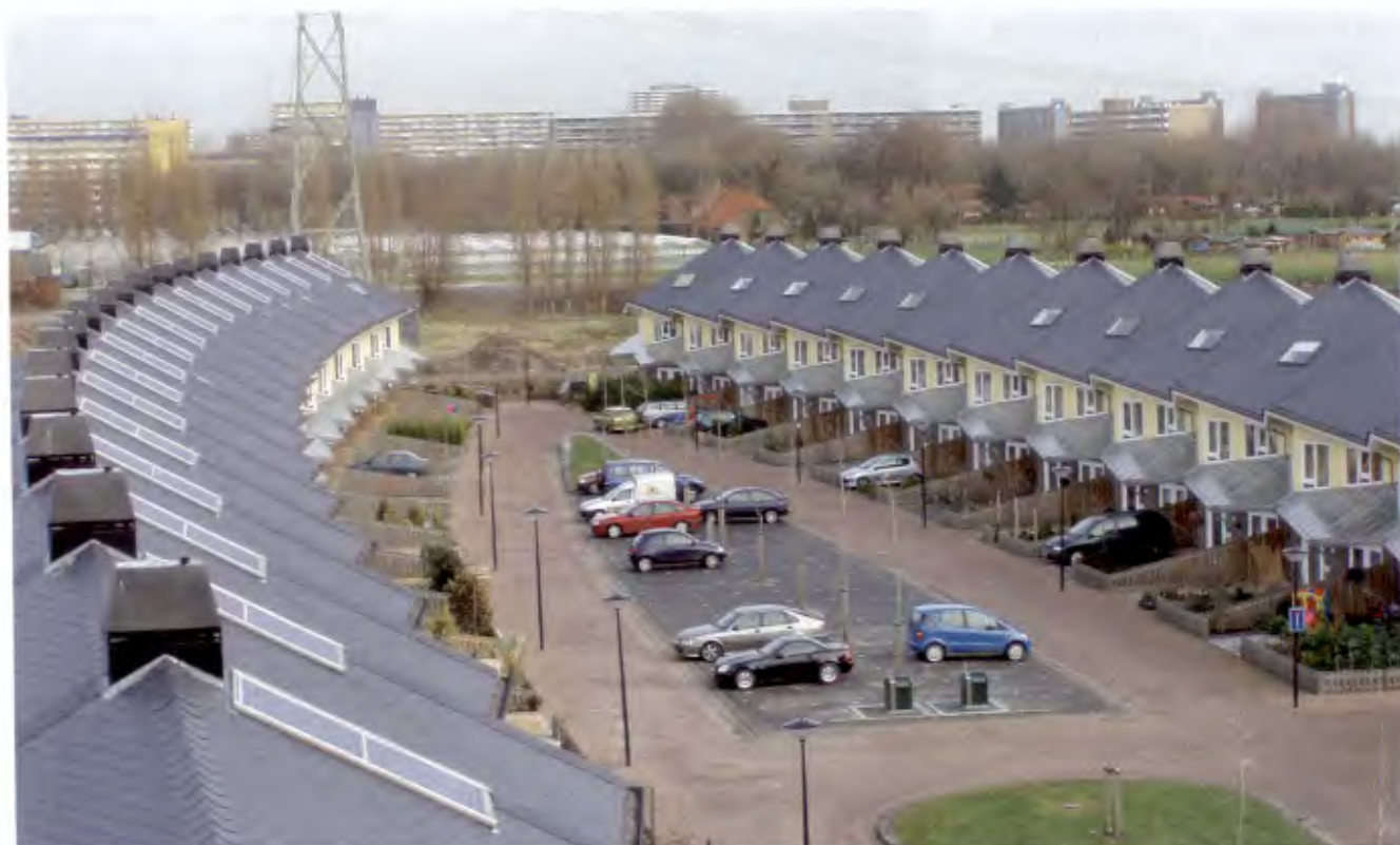
Voorbeeld van een wijkje waar op een juiste en nette manier zonnepanelen op het dak zijn verwerkt.
