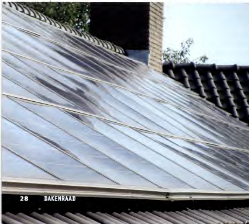
Het systeem is duidelijk niet door een vakman aangebracht; het golft over het dak heen.
