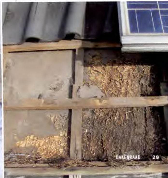
Het dakbeschot is aangetast door lekkage. Oorzaak? Een slecht aangebracht zonne-energiesysteem.
