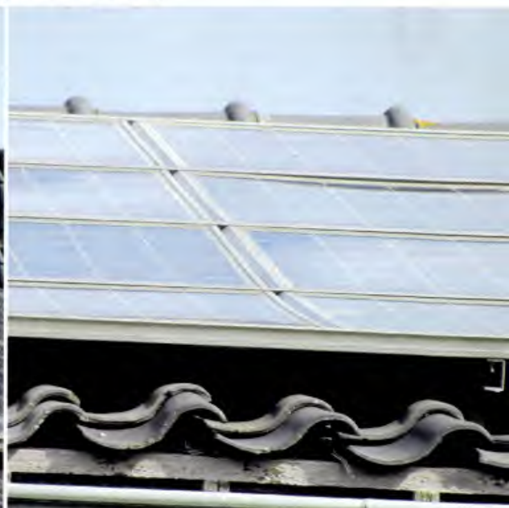
Het systeem is duidelijk niet door een vakman aangebracht; het golft over het dak heen.
